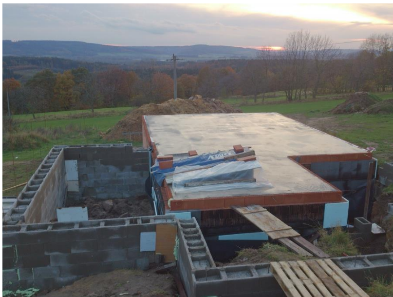
Obr. Stavba domu svépomocí
