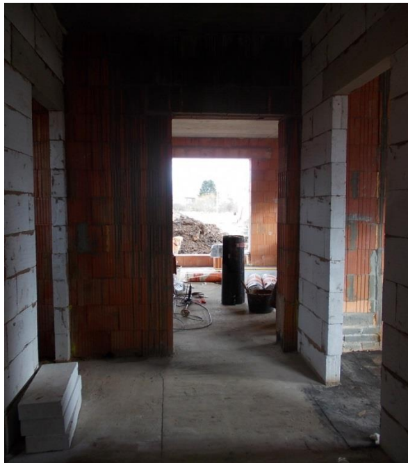
Obr. Stavba domu svépomocí
