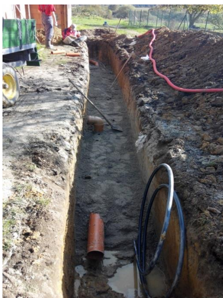
Obr. Stavba domu svépomocí
