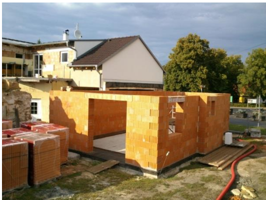
Obr. Stavba domu svépomocí
