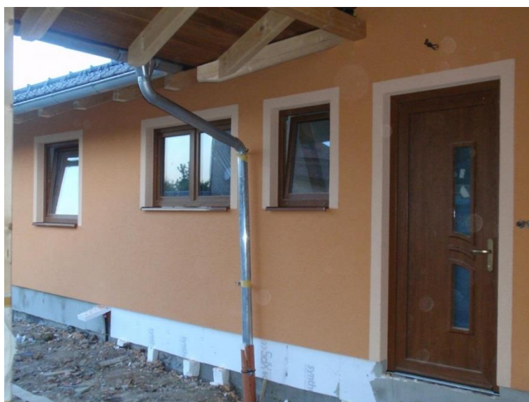
Obr. Stavba domu svépomocí
