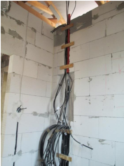
Obr. Stavba domu svépomocí
