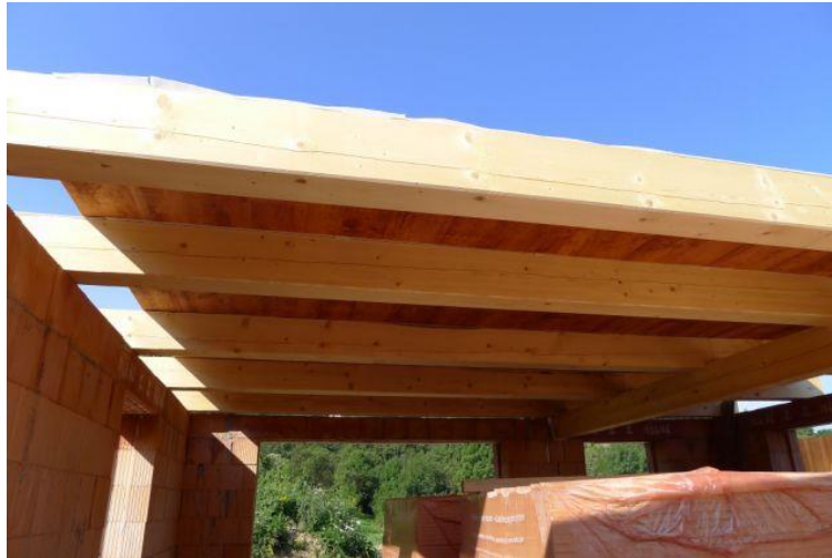
Obr. Stavba domu svépomocí
