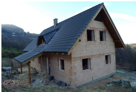
Obr. Stavba domu svépomocí
