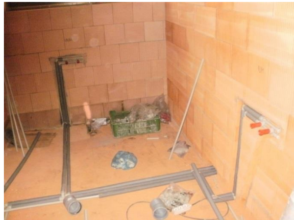
Obr. Stavba domu svépomocí
