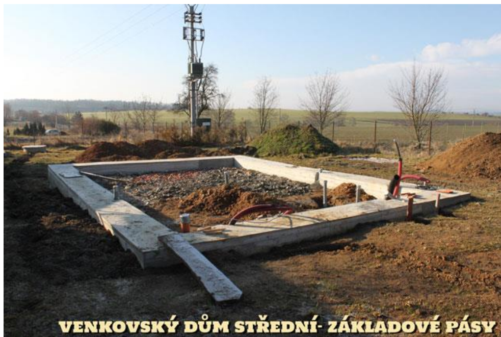
Obr. Stavba domu svépomocí
